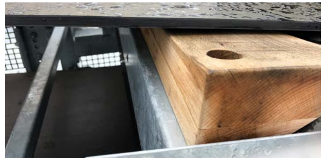
Bild 1: Füllstück an der Antriebstrommel
