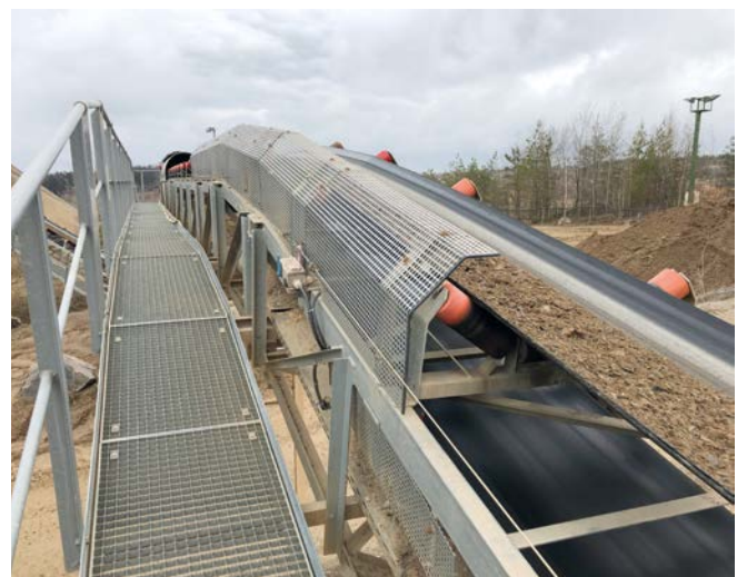
Bild 6: Knickrollen durch Schutzgitter gesichert
